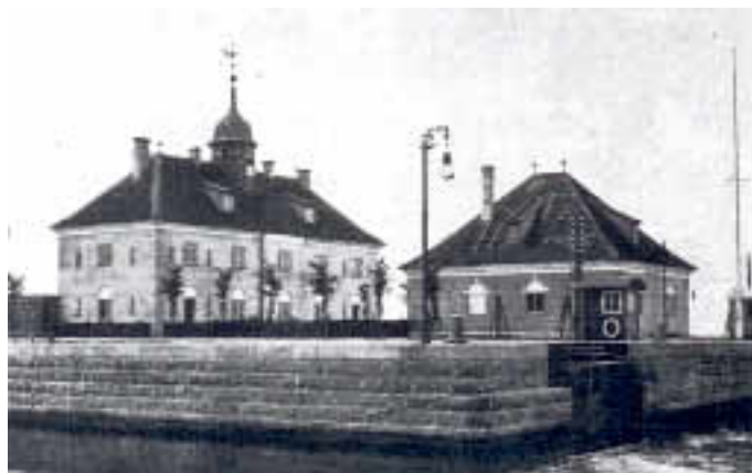
La Cour møllen og husene på Sluseholmen. Maskinhuset, der ses forrest, rummer bl.a. motor og batterilager. (9)
