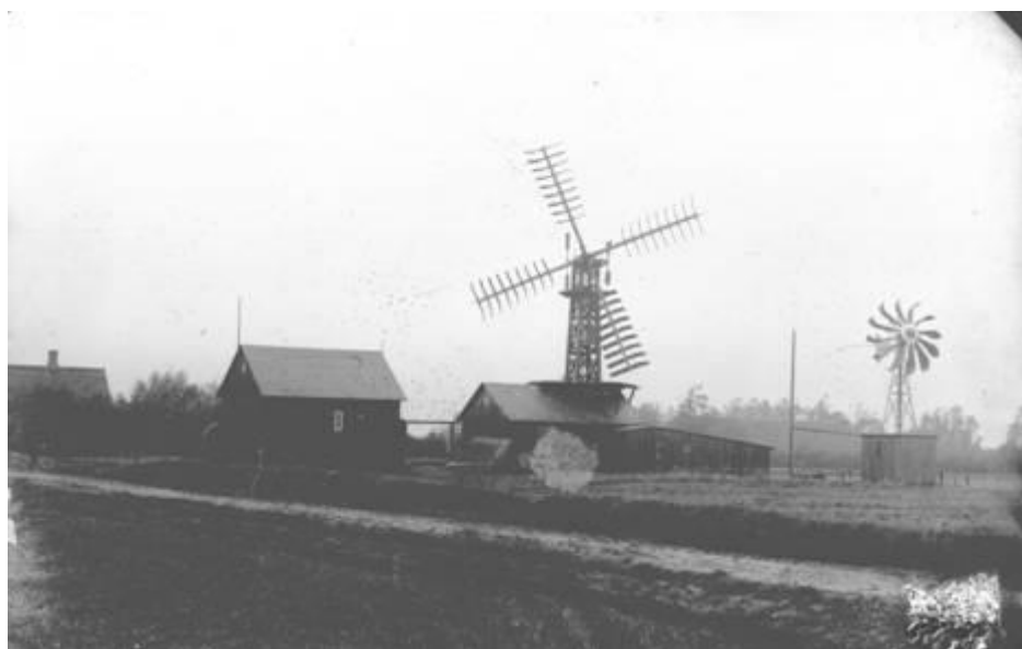
Figur 2: Forsøgsmøllen 1896 med Chr. Sørensens 12-vingede keglevindfang, den i brevet af 6/8 omtalte ”større motor”, til højre.
