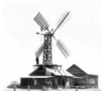
Billedet af den første vindmølle i Askov fra 1891, der leverede strøm til elektrolyse af vand til ilt og brint, findes på en original glasplade, der opbevares på Sønderskovmuseet i nærheden af Askov.
